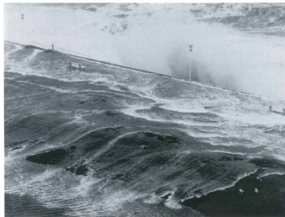
Abb. 3: Durch Wellenüberlauf am Deckwerk an der Kaiserwiese während der Sturmflut vom 3. 1. 1976 fließen erhebliche Mengen Wasser in die Stadt Norderney
