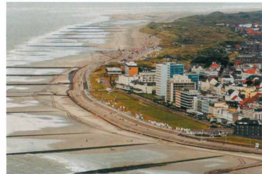
Abb. 1: Übersicht über den durch Bühnen und Deckwerke geschützten Westkopf von Norderney mit Blick auf Kaiserwiese, Georgshöhe und Januskopf
