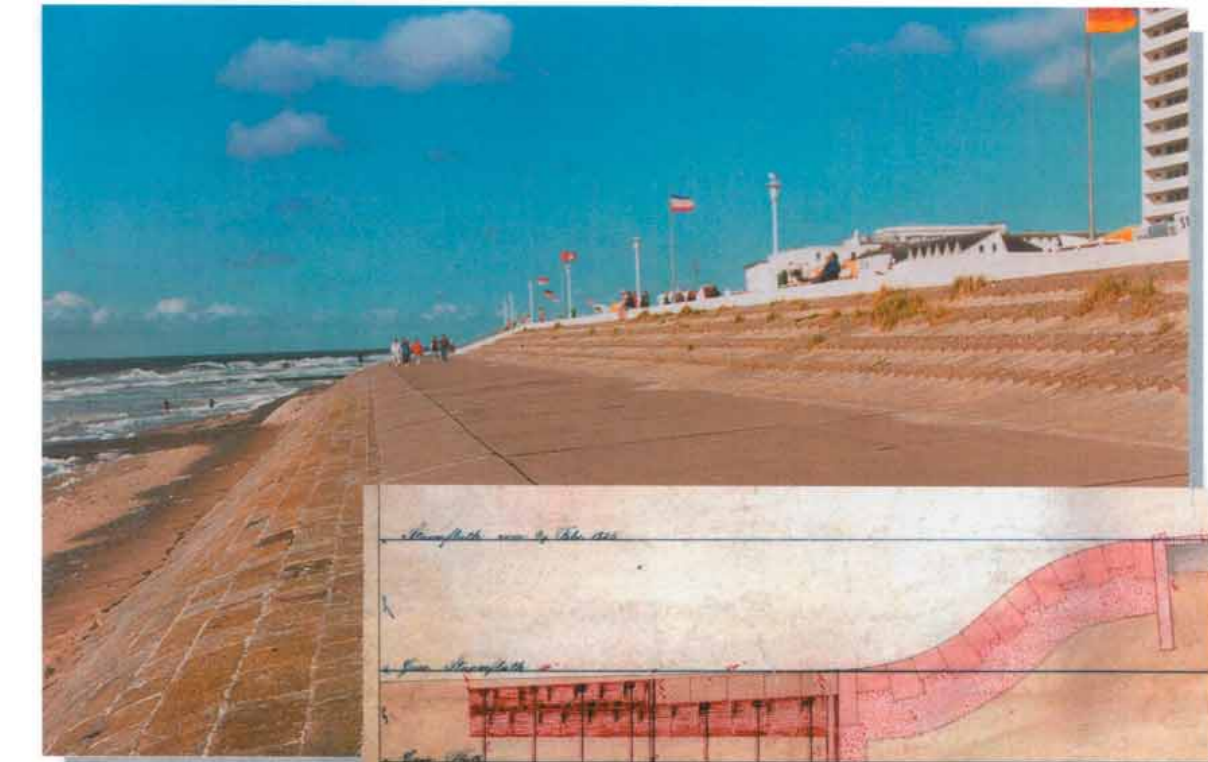
Abb. 9: Sanierung des historischen S-Profiles durch Aufscheiden der alten Fugen, Neuverfugung mittels Trockenspritzverfahren und Hinterpressung
