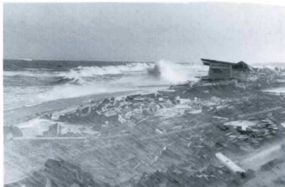
Abb. 2: Schwere Zerstörungen am Januskopf nach der Sturmflut vom 16. 2. 1962
