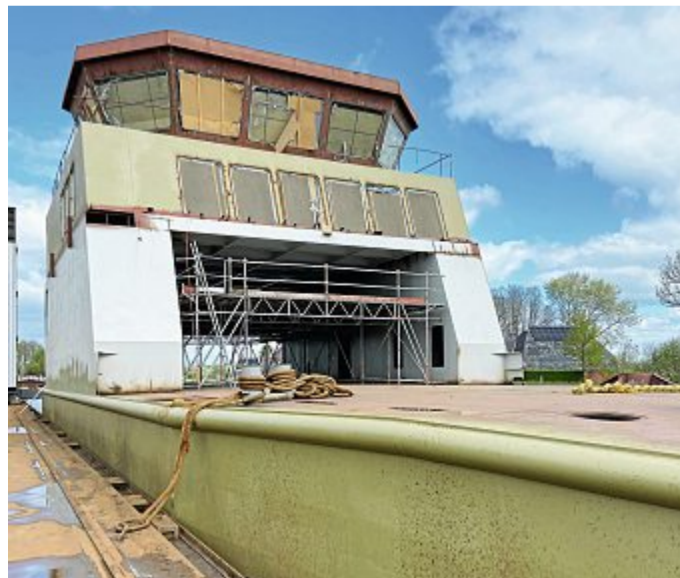
Auch die Brücke wurde bereits montiert.
